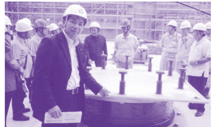
那覇市新庁舎免震構造調査視察
